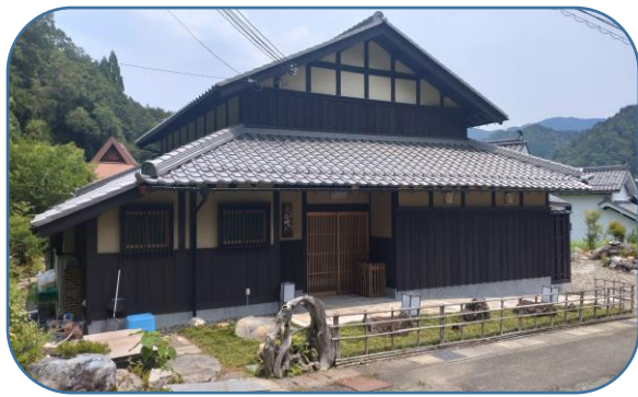
【曾祖母すうさんの住んでいた古民家を改装した店舗】
